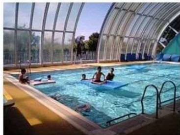
茅ヶ崎養護学校プール
