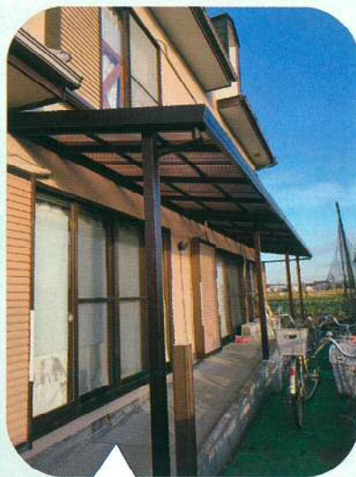
ベランダ撤去後に 屋根を設置しました
